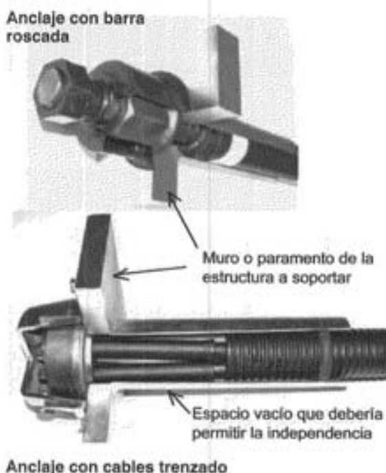
FIGURA 34. ESQUEMAS DEL EMPOTRAMIENTO SUPERIOR DE LOS ANCLAJES ACTIVOS
